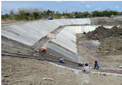
Pekerjaan Beton B.0 66,44 %
