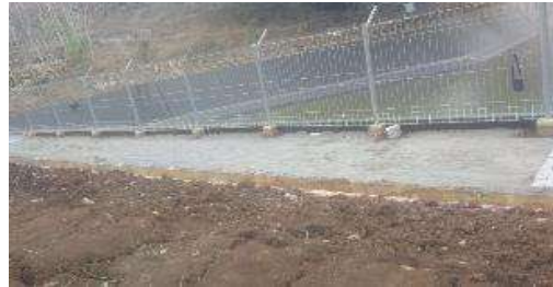
Pekerjaan paving blok 95%
