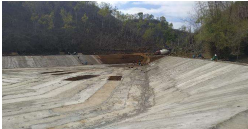
Pekerjaan Beton K.175 80,345%
