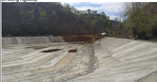
Pekerjaan Beton K.175 95%
