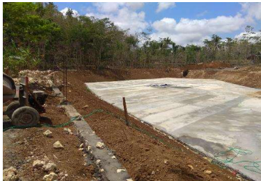
Pekerjaan psangan batu 98,347%
