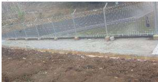
Pekerjaan paving blok 100%
