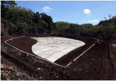
Pekerjaan Pembeton B.0 94,247%
