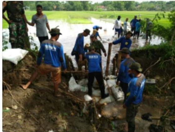
Progress penutupan darurat bobolan tanggul S.Cino.
