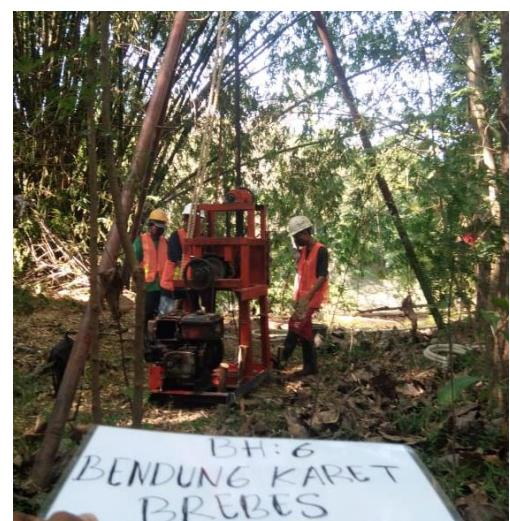
Survey Geoteknik Pengeboran Inti (Bor Mesin)
